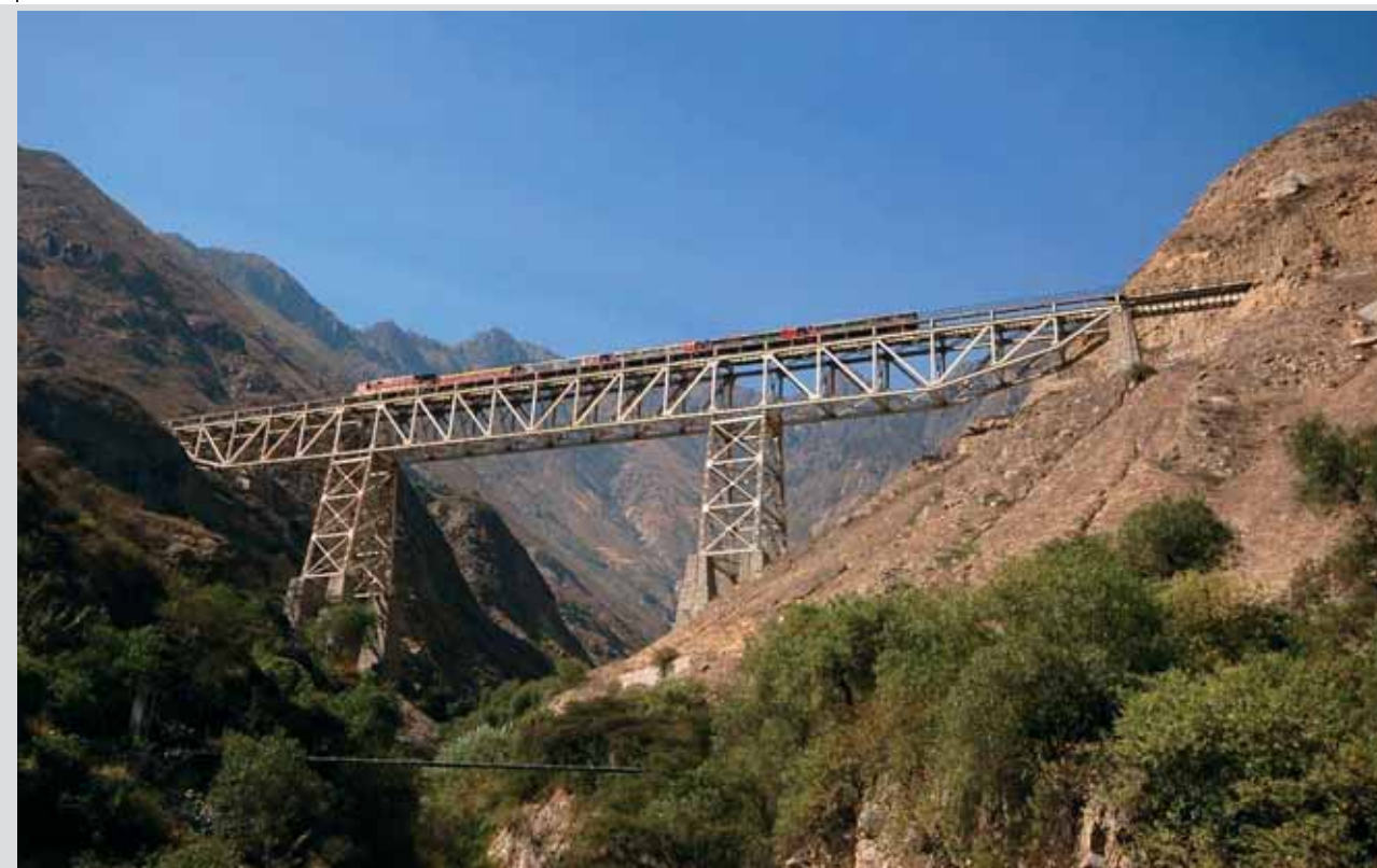
Jeden z wiaduktów linii kolejowej Callao–La Oroya; widok współczesny
